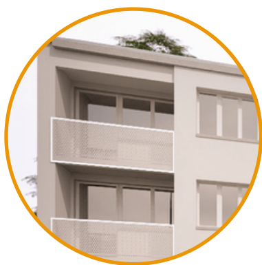
Habillage des garde-corps des loggias en tôle perforée thermolaquée de teinte blanche
