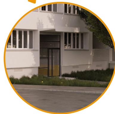
Remplacement des menuiseries extérieures des halls d'entrée
