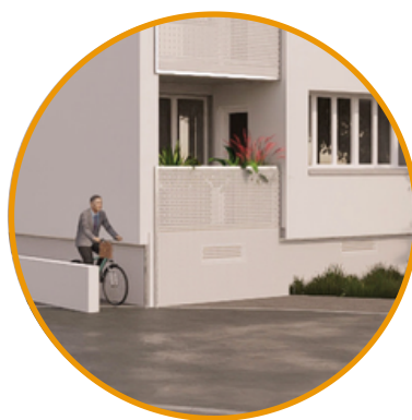
Habillage des soubassements du RDC en tôle perforée thermolaquée de teinte blanche
